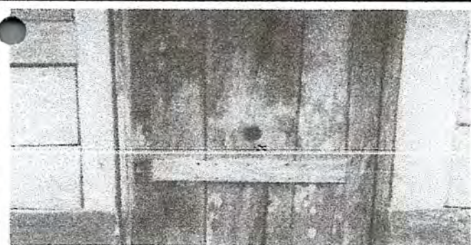
Foto 5: Aca se logra observar la puerta en mal estado misma que requiere sustitucion.
